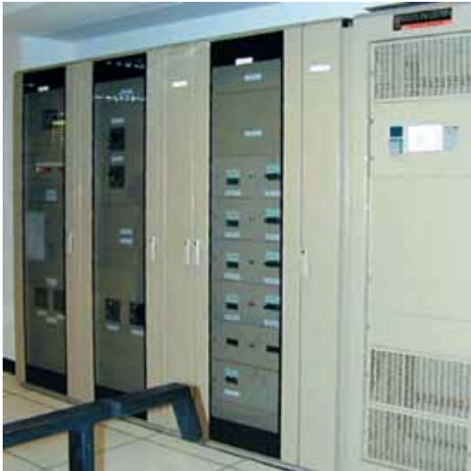
Распределительные щиты низкого напряжения Prisma P
